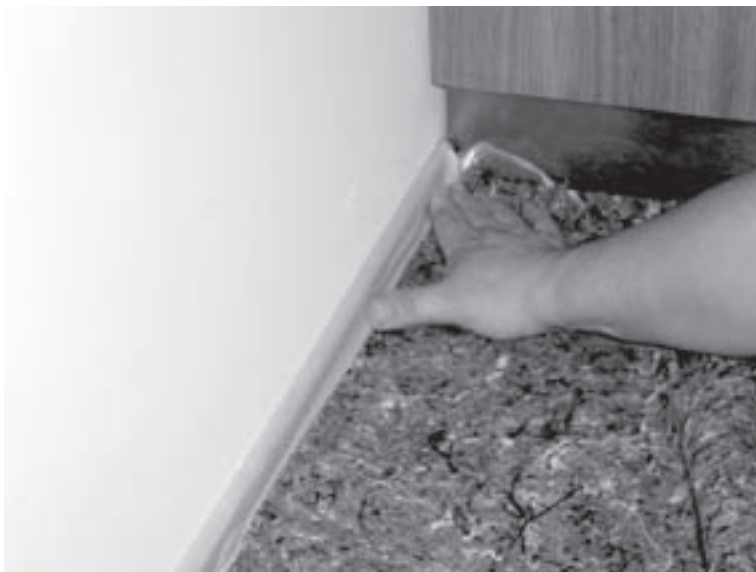
Obr. 3 Oblepení lišt a zakrytí podlahy filcem
