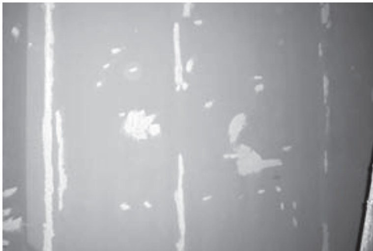
Obr. 6 Vyspravení podkladu
