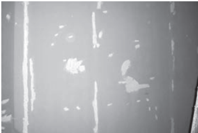
Obr. 6 Vyspravení podkladu
