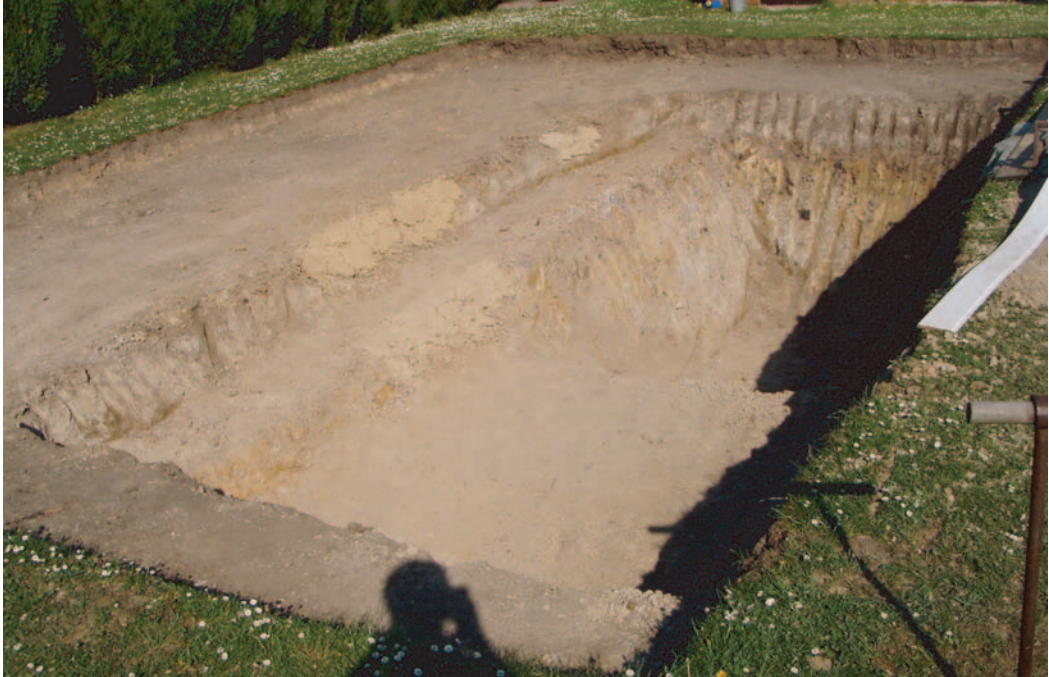
obr. 9 Výkop jednodílného jezírka (hloubka 2,2 m)
