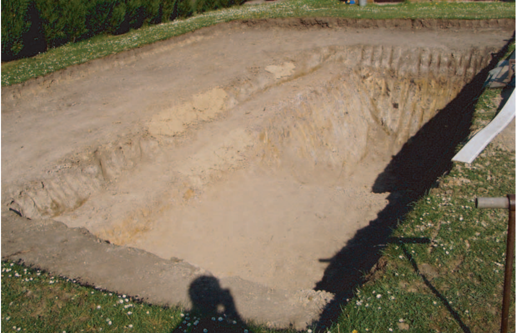
obr. 9 Výkop jednodomového jezírka (hloubka 2,2 m)
