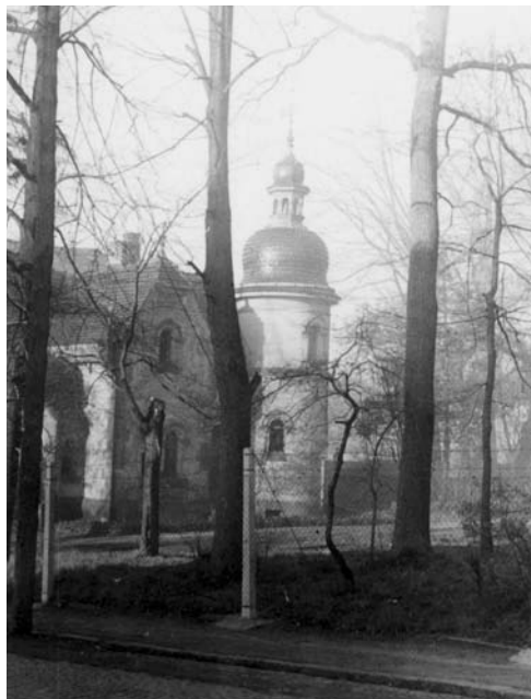
Dnes zbořený dům pro služebnictvo při Hielleho vile (Státní okresní archiv Děčín)
