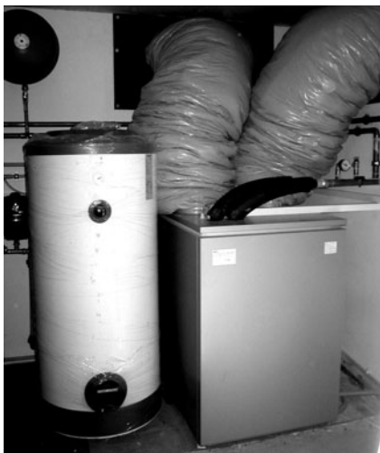
Obr. 4 Tepelné čerpadlo vzduch/voda – vnitřní provedení
