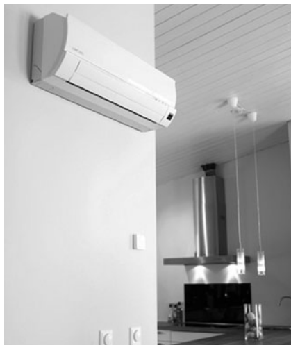
Obr. 6 Tepelné čerpadlo vzduch/vzduch – vnitřní jednotka
