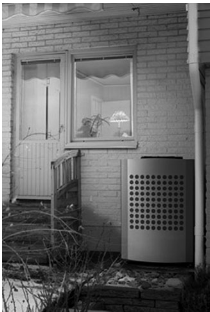
Obr. 3 Tepelné čerpadlo vzduch/voda – venkovní jednotka
