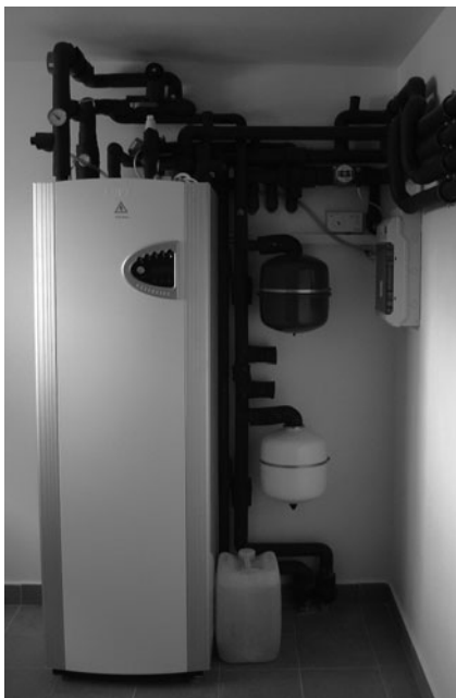
Obr. 2 Tepelné čerpadlo země/voda
