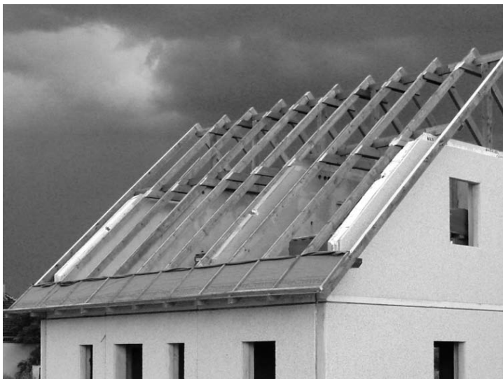
Obr. 3 Krov opatřený nátěrem
