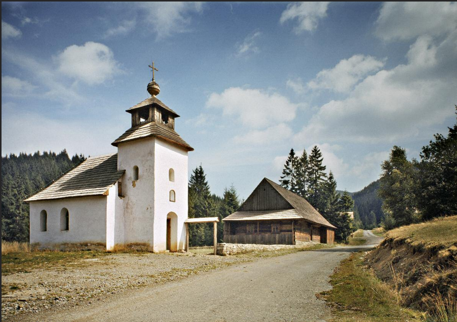
Murovaná kaplnka zo Zborova nad Bystricou zo začiatku XIX. storočia
