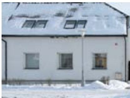
Obr. 1 Dům se třemi různými okny vedoucími do jediného prostoru
