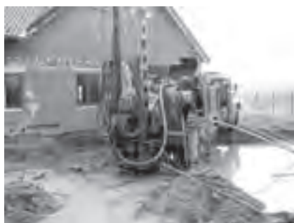
Obr. 6 Jádrové vrtání v pevných horninách
