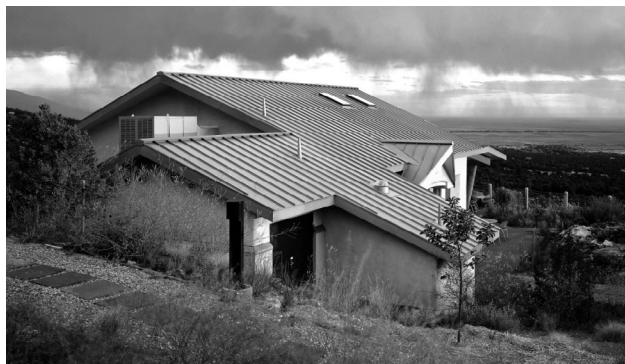
Obr. 2.3 Sedlová střecha – foto a schéma (objekt mezinárodního institutu Shumei, zdroj: Rhein-zink ČR, s. r. o.)
