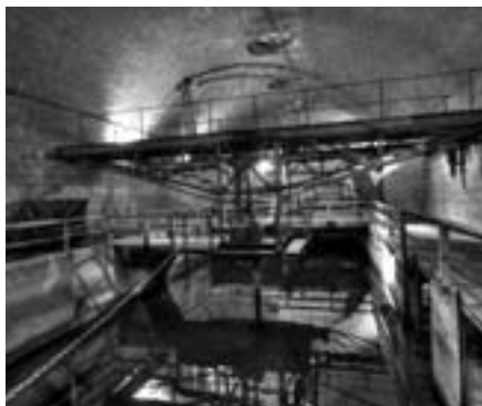
Obr. 4 Lapák písku; původní pražská čistírna
