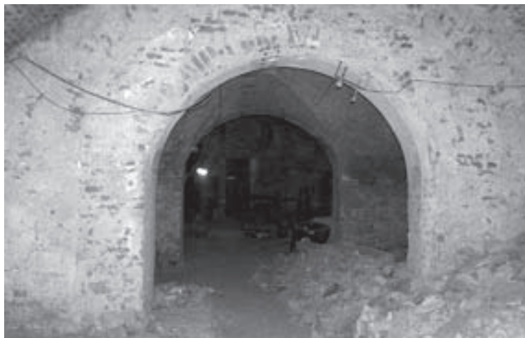
Obr. 2.3 Pohled do suterénu historické budovy
