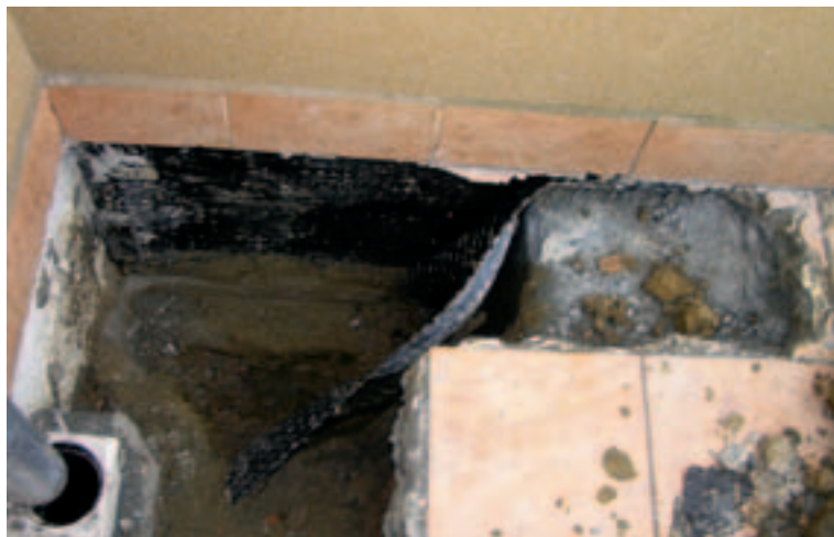
| Obr. 2.4 Kopaná sonda u obvodového zdiva za účelem zjištění stavu hydroizolace
