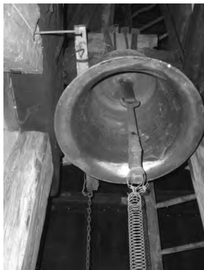
Obr. 3.1 Srdce přichycené pružinou k podlaze zvonice. Nevhodná a nebezpečná úprava provedená pro usnadnění zvonění a dosažení silnějšího zvuku. Vede k většímu opotřebení zvonu a má negativní vliv na hlas zvonu: zkrácené vyznívání po úderu, příliš rychlý rytmus. Foto Jan Kopřiva
