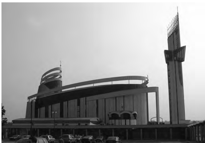
Obr. 2 Bazilika Božího milosrdenství v Krakově-Łagiewnikach (Polsko). Vedle chrámové lodi je postavena samostatně stojící zvonice
