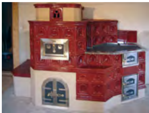
Obr. 2.3 Kování u sporáku s teplovodním výměníkem
